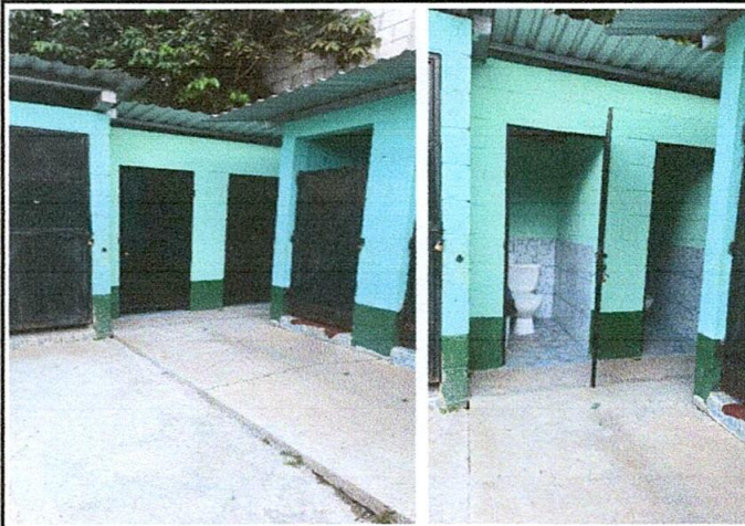
Foto1: Remozamiento Servicios sanitarios y sus accesorios
