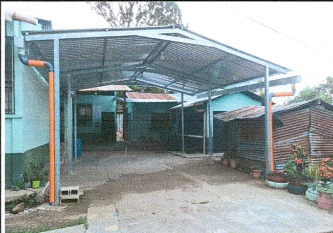
Foto 2: Cubierta de Lamina
